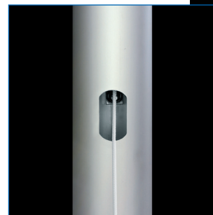
Hissseilschloss geöffnet
